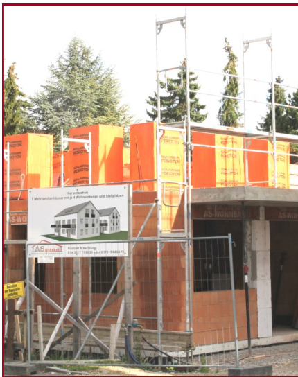
In der Ostendstraße wird nachverdichtet
