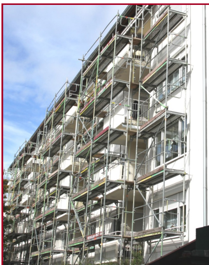
In diesem Jahr starteten die Arbeiten in der Ostend / Rohrenfelder Straße
